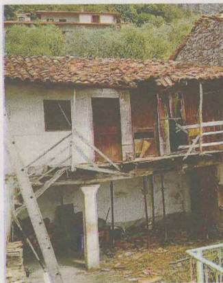
L'intervento di recupero nel complesso del castello a Zorzino
